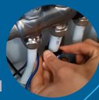
Durch 2 Temperaturfühler, welche an Vor- und Rücklauf montiert sind, erfasst EGO die Spreizung und regelt über seine künstliche Intelligenz die Wassermengen:
