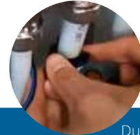
Durch 2 Temperaturfühler, welche an Vor- und Rücklauf montiert sind, erfasst EGO die Spreizung und regelt über seine künstliche Intelligenz die Wassermengen:
